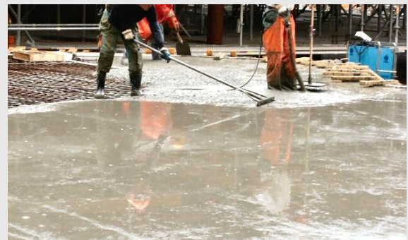
Betongarbete vid gjutning av golv
